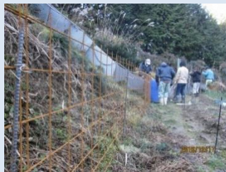
獣害防止柵の設置
