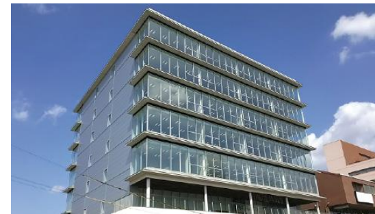
(統計データ利活用センター 外観)
