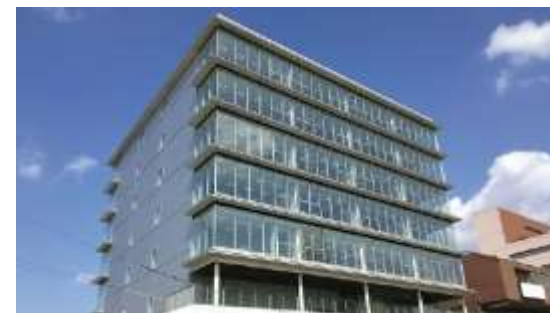
(統計データ利活用センター 外観)
