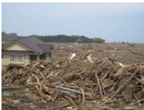
山元町内被災状況
