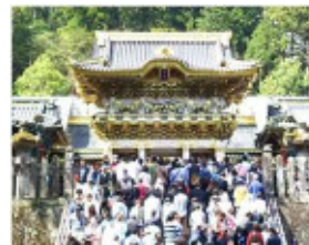
「国宝東照宮陽明門」 平成30年度に修理完了
