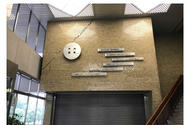
壁に亀裂が入った市役所ロビー
