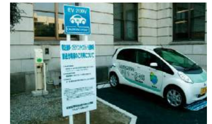
普通充電器(200V)の一例(滋賀県庁舎)
