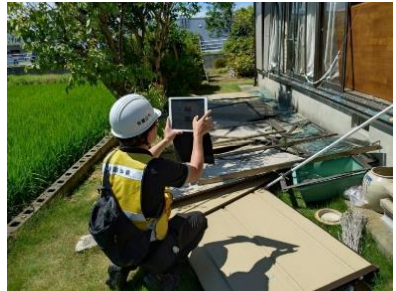
住家被害認定調査(和歌山県)
