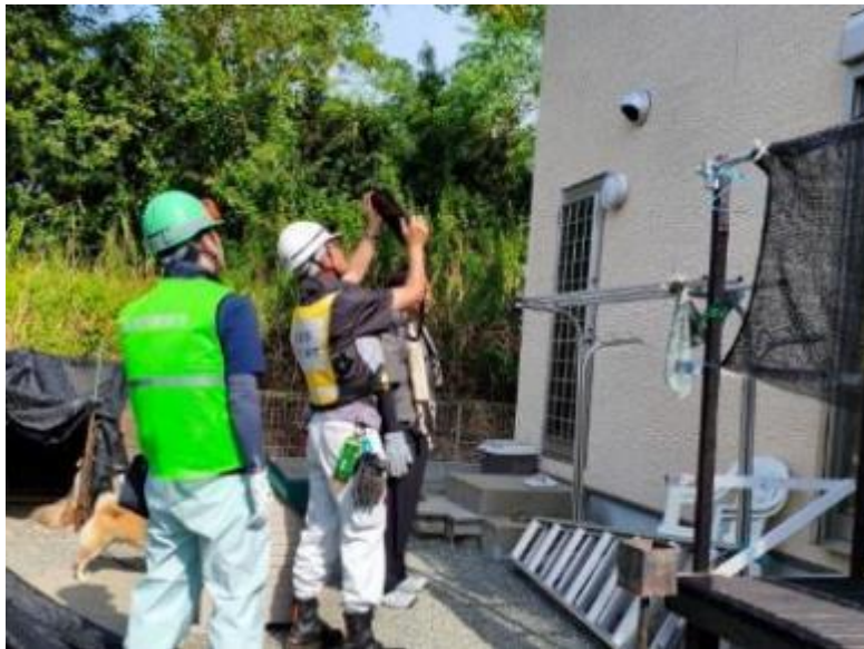
住家被害認定調査(滋賀県)
