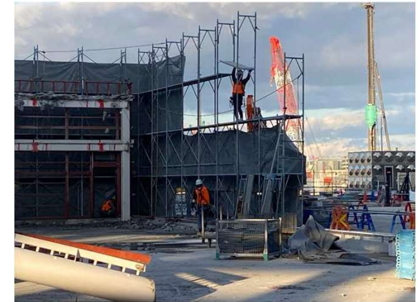
【足場解体状況：R8.1.6】
