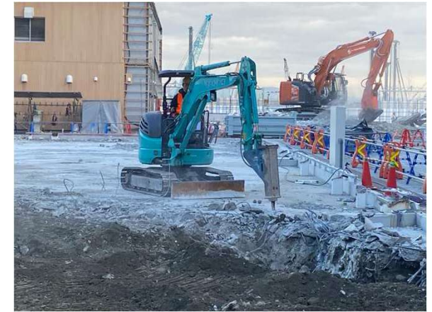
【基礎解体状況：R8.1.9】
