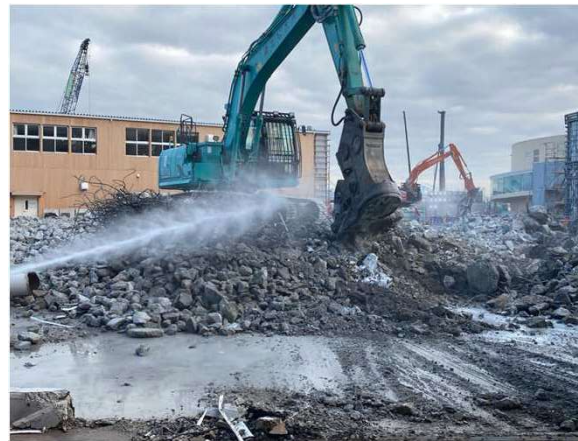
【基礎解体状況：R8.1.9】
