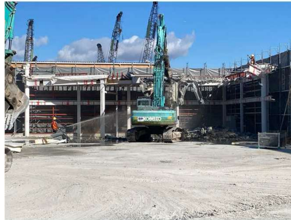
【躯体解体状況：R8.1.6】
