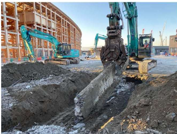
【基礎解体状況：R8.1.7】
