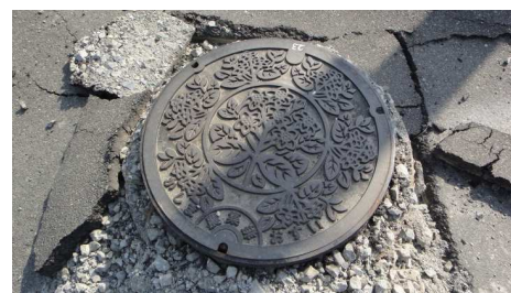
東日本大震災時の集落排水施設の被災状況（福島県南相馬市）
