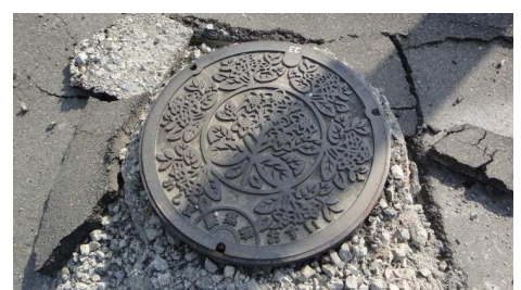
東日本大震災時の集落排水施設の被災状況（福島県南相馬市）
