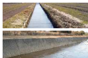
矩形水路・急勾配護岸による 横断連続性の喪失
