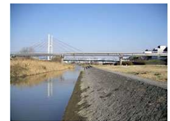
低水護岸整備に伴う水陸移行帯の消失 (猪名川)
