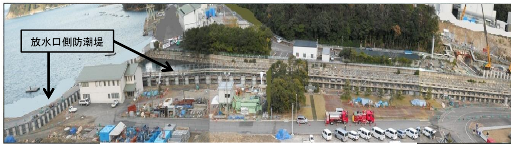
放水口側防潮堤
