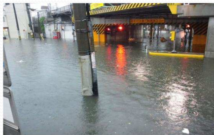
平成24年8月14日の浸水状況 (大阪市中心部)
