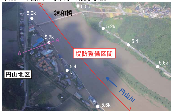
平成25年台風18号洪水の浸水状況
