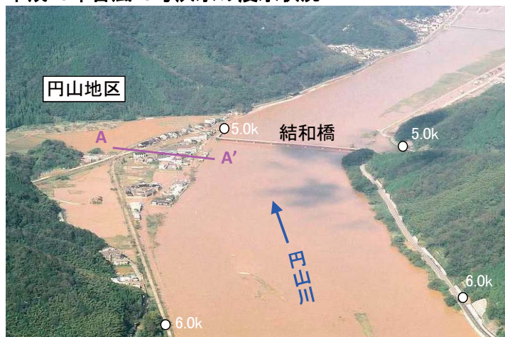
平成16年台風23号洪水の浸水状況
