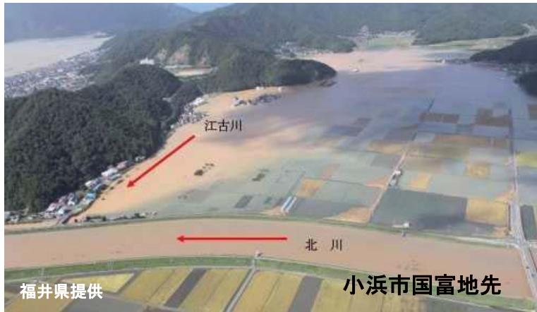
北川水系江古川 越水状況
