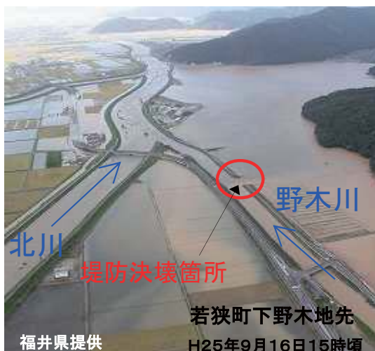
北川水系野木川 堤防決壊
