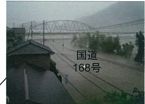
◆国道168号 冠水 新宮市熊野川町
