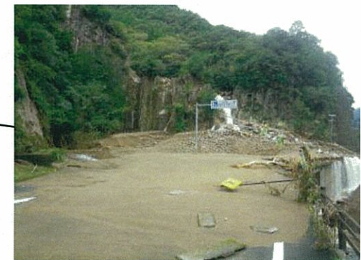
◆国道168号 崩土 新宮市高田
