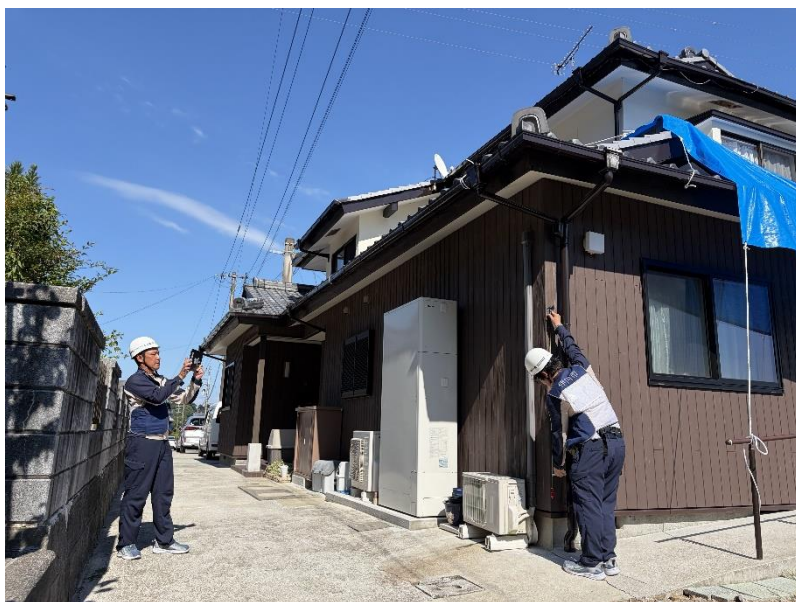
家屋被害認定調査(兵庫県)
