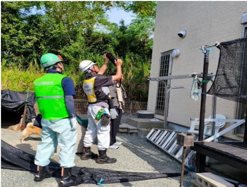
住家被害認定調査(滋賀県)
