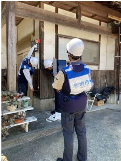
住家被害認定調査(堺市)
