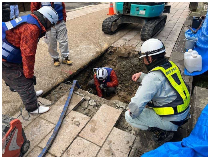
上水道復旧支援(能登町)
