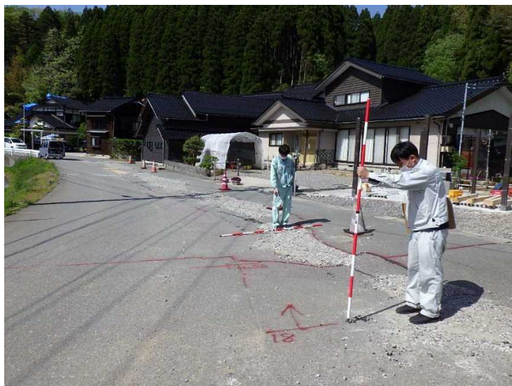
土木復旧業務(志賀町)
