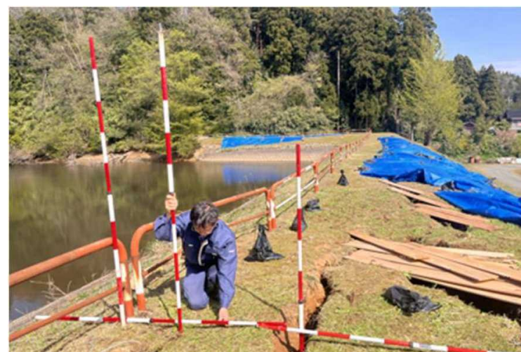
ため池復旧工事測量(珠洲市)
