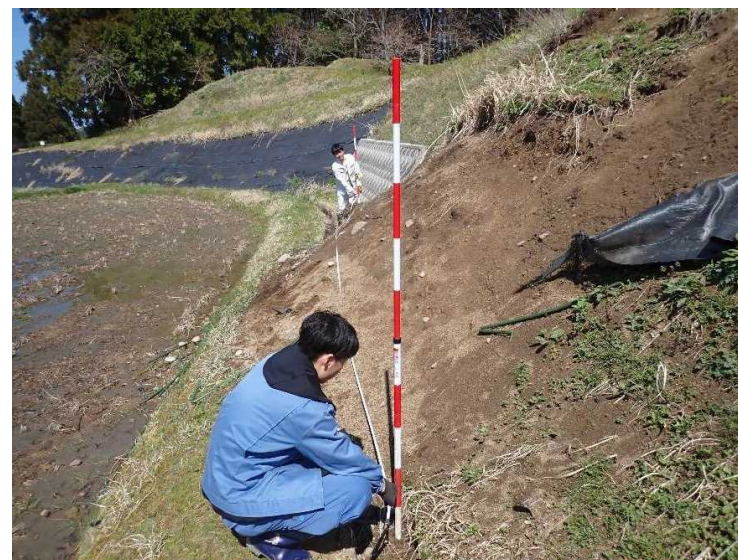
農業用施設の災害復旧(輪島市)
