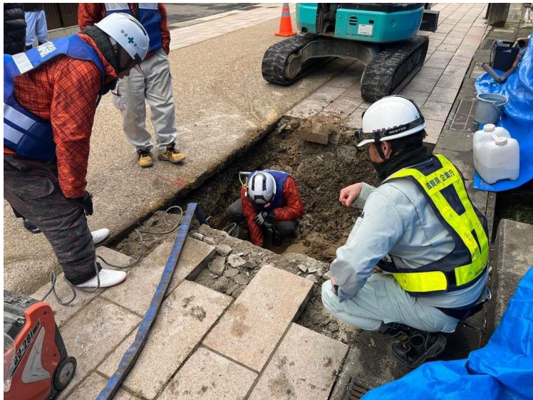
上水道復旧支援(能登町内)
