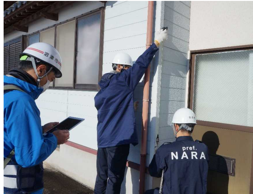
家屋被害認定調査の様子(穴水町内)
