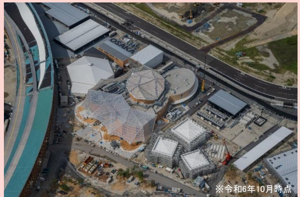
※令和6年10月時点 関西パビリオン周辺現場写真
