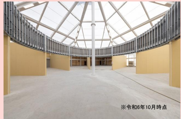
※令和6年10月時点 関西パビリオン現場写真
