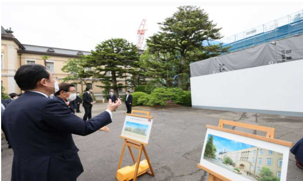
文化庁移転工事現場を視察する岸田総理
