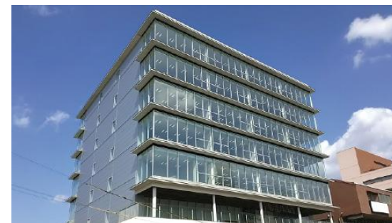
(統計データ利活用センター 外観)
