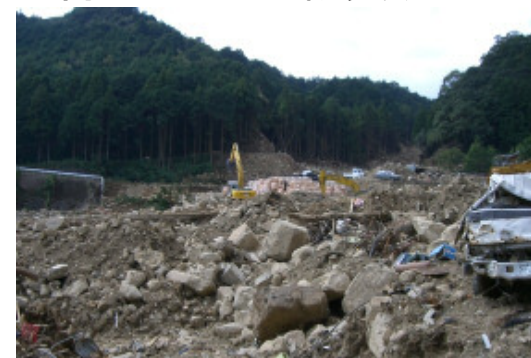
那智勝浦町土石流により壊滅した地区
