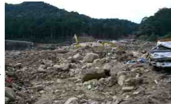
那智勝浦町 土石流により壊滅した地区
