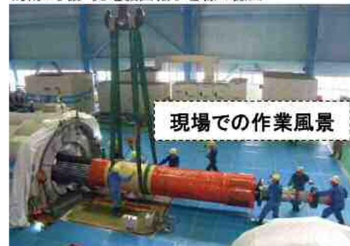
海南2号機 発電機回転子巻線の搬出
