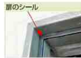
扉のシール施工
