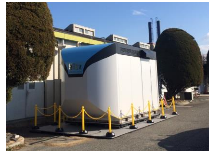
【日立造船】 20kW級 SOFC 都市ガス
