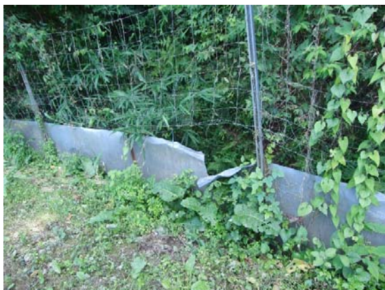
破損して侵入を許してしまった柵
