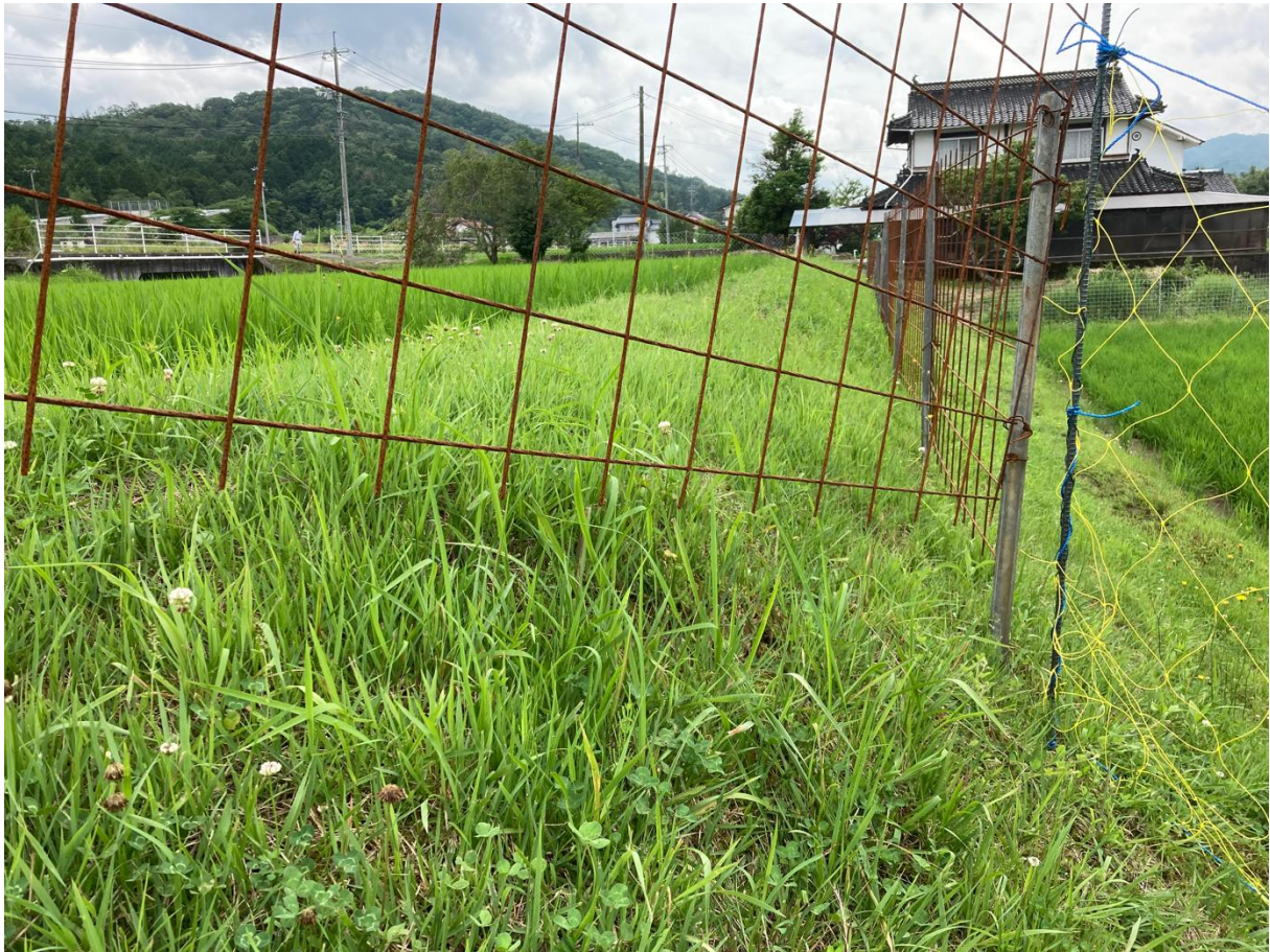
ワイヤーメッシュ柵の接地が不適切な事例。接地面の固定が十分であれば、侵入防止効果は高い
