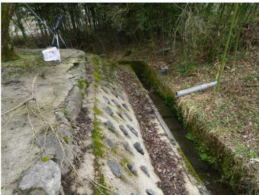
側溝や排水路
