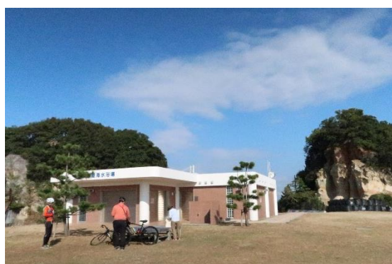
海浜部の「岩屋海水浴場」トイレ（閉鎖中）、 正面右手に大和島
