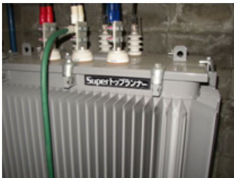
高効率のトッランナー変圧器による 損失電力の大幅削減
