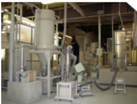
塗料回収装置による使用塗料の削減
