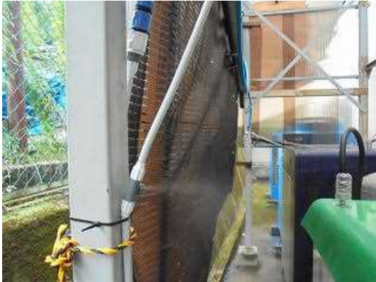
写真⑥-1【昨年度の5Sグランプリ】 コンプレッサー付近の温度上昇防止の 為、自作ミストを設置
