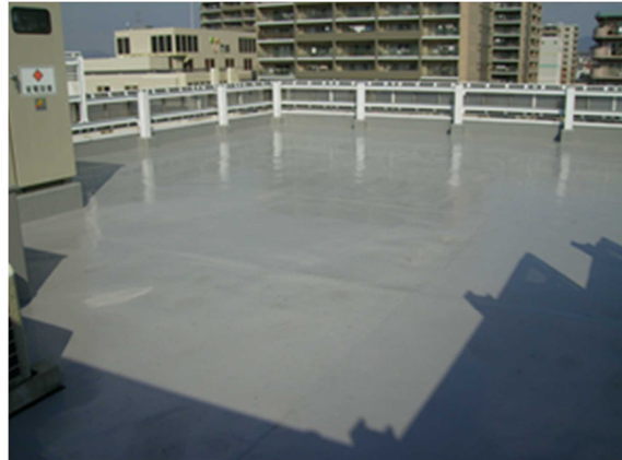
【熱遮蔽塗装による節電の取り組み（屋上）】
